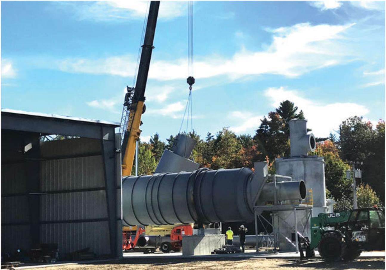
T&D Wood Energy的颗粒工厂由缅因州的Player Design公司设计和建造。该工厂采用了Player专有的熔炉和干燥系统，以及集成控制系统，以最大限度地提高产量并减少能源使用。照片：T&D WOOD ENERGY
