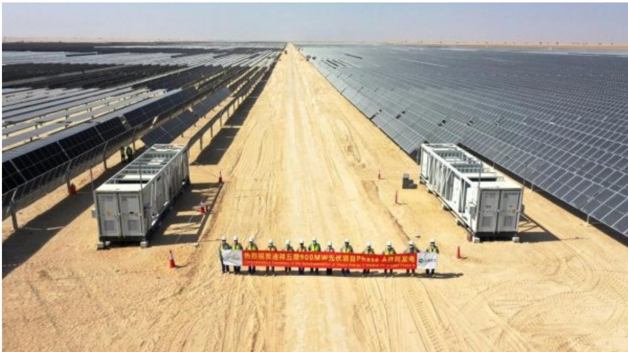
由于项目深处沙漠腹地，气候环境十分恶劣，光伏板积灰严重影响发电效率，为稳步推进发电计划，项目团队一方面组织各参建单位，争分夺秒开展扫尾和消除缺陷工作，另一方面克服当地50摄氏度以上的酷热天气，确保清理进度，满足并网速度。截至目前，并网负荷已达150MW，全力向300MW满发目标努力，力争早日通过可靠性试运行和性能试验达标。
