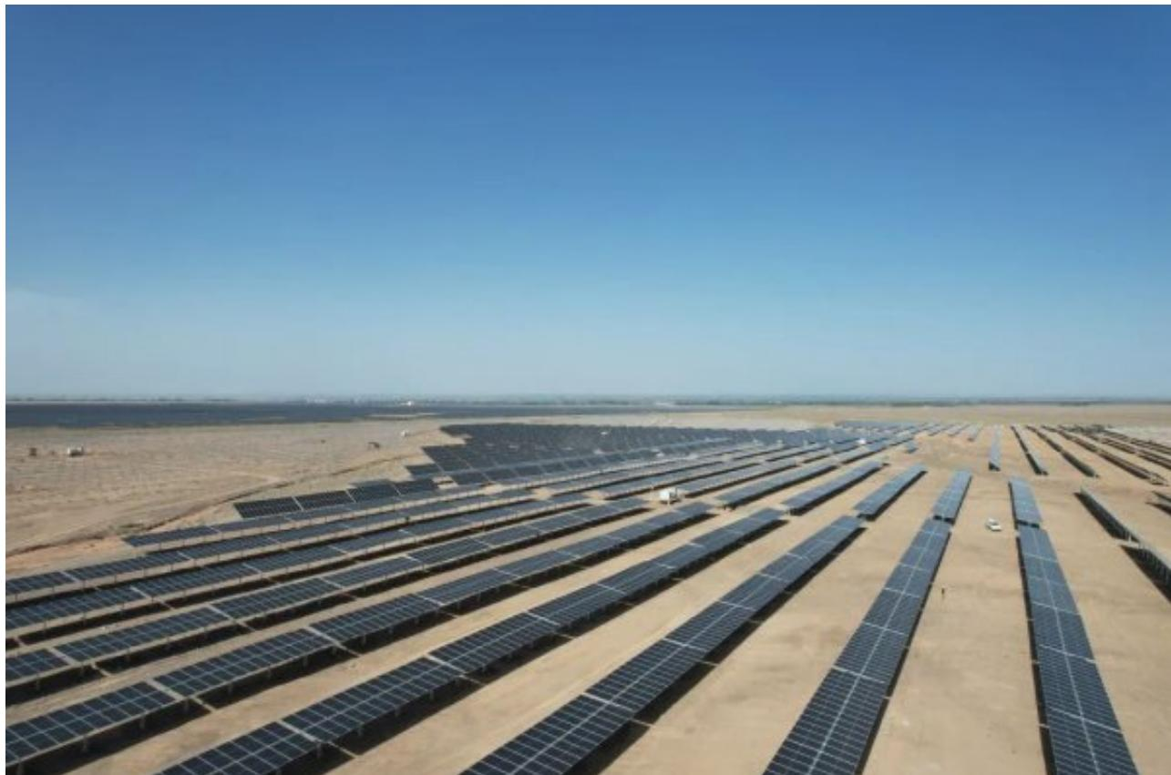
该项目位于甘肃省酒泉市肃州区东洞滩光伏示范园区，由东方电气集团投资建设，占地面积1800亩，核准装机容量为50兆瓦，由16个发电单元，超过11万块高效双面双玻组件组成。充分发挥了集团公司各单位在项目建设、智慧能源管理、储能及氢能设备方面的优势，配置10MW/20MWh高效锂电池储能及综合智慧能源管理平台、电解水制氢储氢加氢一体化系统，光伏、储能设备以及负载设备能够无差别对等互联，大幅提升可再生能源的消纳能力，在实现削峰填谷、出力平抑，缓解电网调峰压力的同时确保电网安全运行。
