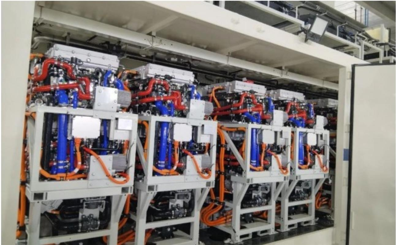
开元化工是河南知名氯碱国企，该项目是国内氯碱工业首个将副产氢气作为能源通过氢燃料电池实现综合利用的尝试，也是目前国内首个商业化运行且功率最大的燃料电池热电联供项目，可以为厂区解决2MW的供电，约7GJ/h的余热可供回收，同时为周边加氢站供氢。整个项目规划使用10-20年，年运行时间8000h，预计4-5年可以回收成本，长期持续运行则收益越大。
