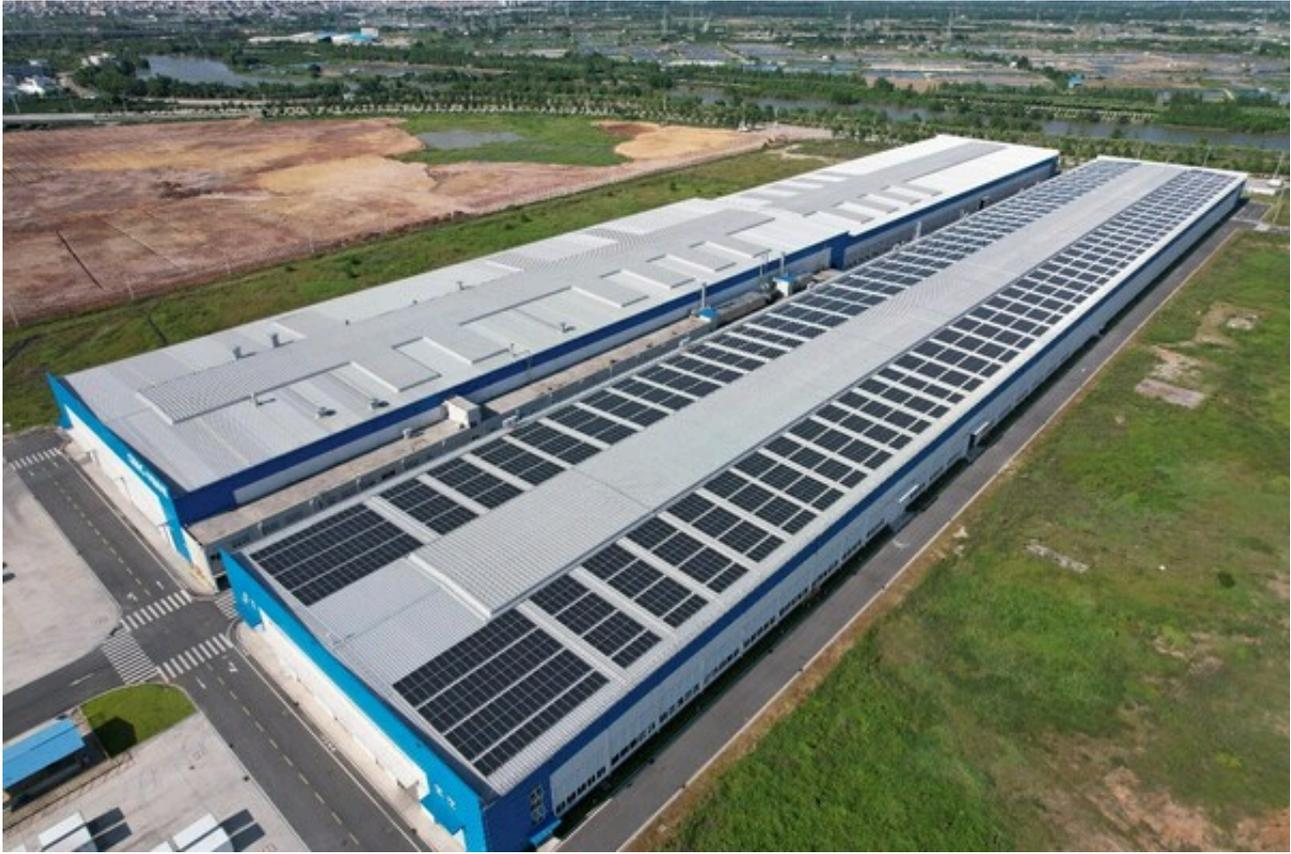
以国家级绿色工厂扬州通华在绿色发展和节能减排方面的发展为例，其重视清洁能源使用，2023年已建成5.88MWp光伏电站，年发电量约600万千瓦时，并新规划建设4.2MWp光伏电站，建成后预计年发电量约400万千瓦时，预计每年可减少温室气体约7,035吨二氧化碳当量；同时采取多项节水措施，年节水率达40%，并全面使用LED灯具，节能灯具占比100%。
