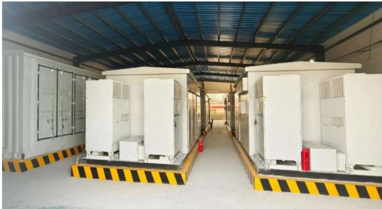
储能系统安全性能高、使用寿命长，充放电循环可达到8000次以上。电芯采用全生命周期安全边界设计，不含易燃的有机溶剂，冷却方式采用高效智能液冷温控系统，系统层级温差小于5℃，温度一致性使系统循环寿命提升10%，降低辅助功耗20%。配备智能管理、智能保护等功能，实现了系统的经济高效和极简运维。
