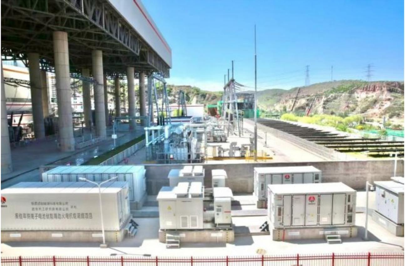
该项目建设规模10MW/5MWh，采用陕煤技术研究院“9MW/4.5MWh磷酸铁锂离子电池+1MW/0.5MWh钠离子电池”混合配置的首创方案，响应速度达到毫秒级，可瞬间满功率输出，具备强大的短时大功率吞吐能力，能够在额定功率范围内精准调节，不仅有效提升新元公司CFB锅炉火电机组频率调节能力，促进辅助服务增收创效，同时为电网高比例新能源消纳提供稳定调频支撑，相较传统火储联调系统展现出显著技术优势，对构建坚强智能电网具有重要示范意义。（杨琪 常艳强）
