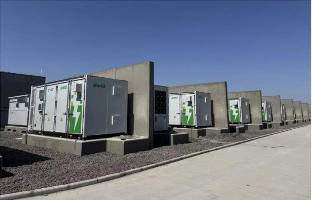
针对江苏北部集中式光伏电站对储能系统安全性、经济性与环境适配性的综合需求，晶科蓝鲸 G2 5MWh大储系统通过行业领先的液冷热管理系统，将电芯温差精准控制在2.5摄氏度以内，配合在电池、电池组、电池簇、集装箱和系统层面提供5层保护，有效抵御高湿、温差变化等复杂环境影响。其94%的RTE充放电效率与8000次循环寿命，在保障高效能输出的同时实现全周期经济性最优，助力当地构建稳定、高效、安全的清洁能源供应体系，加速能源结构绿色转型。
