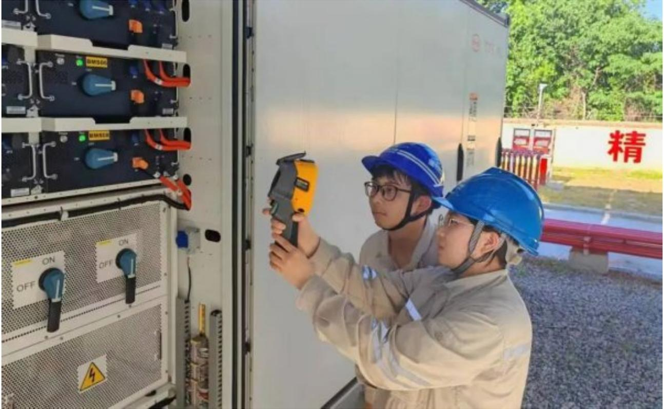
继保班组采用红外热成像技术，通过温度异常快速识别电池簇、连接件等部位的异常升温，该技术手段能够识别多个肉眼难以发现的局部过热点，实现故障源的精准定位，为后续检修提供科学依据。
