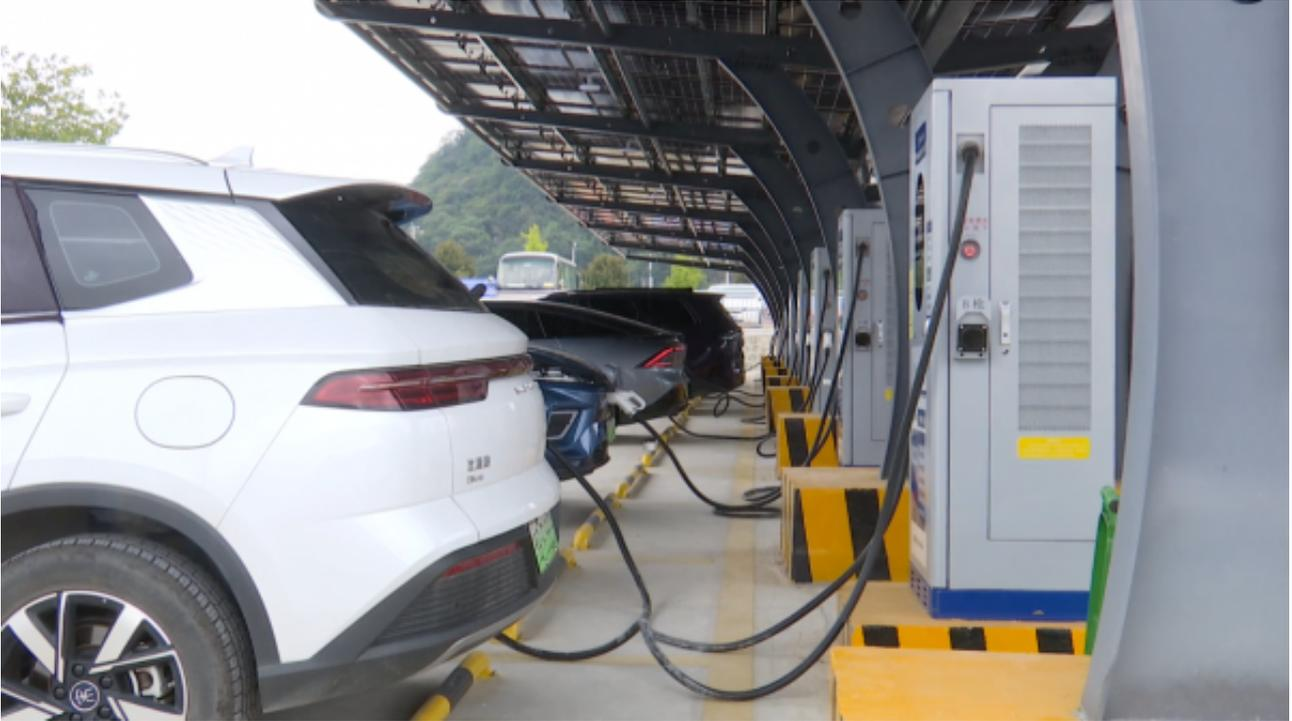
据介绍，光储充电站采用“分布式光伏发电+储能+充电桩”的新型能源服务系统，遵循“自发自用、余电存储、按需放电”逻辑，整合发电、储电、用电端资源，形成能源生产、存储、消费的闭环管理。这一系统不仅能有效控制运营成本，还可在白天通过自主发电满足车辆充电与储能需求，用电高峰时段则释放储能保障运营——既不占用高峰用电指标，又能为车主提供价格平稳的绿色清洁能源。
